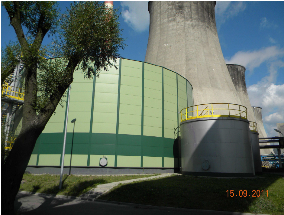
Fot. 2. Urządzenia gospodarki wodnej Elektrowni Łagisza – przygotowanie wody dodatkowej do obiegu chłodzącego
