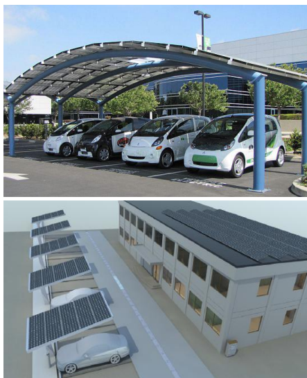
Rys.4. Nieduże parkingowe stacje ładowania pojazdów EV
